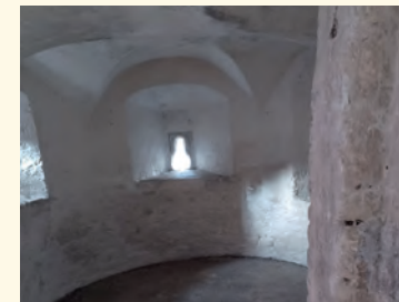
Historische Bausubstanz hier entsteht das kleine Trauungszimmer
